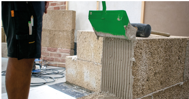
7 Lijm het verticale oppervlak als de blokken geen tand en groef hebben.
