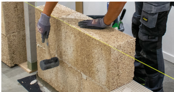
9 Stel bij met een hamer en controleer of alles waterpas is.
