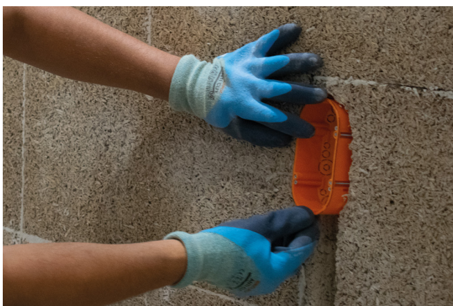
3 Monteer elektriciteitsdozen en elektrische leidingen.
