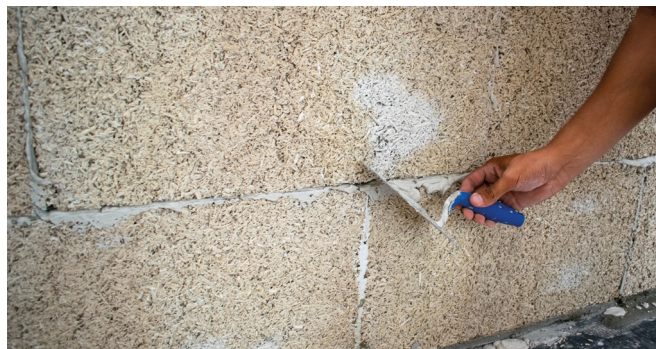
10 Verwijder overtollige lijm met een lijmkam om spookvoegen te vermijden.
