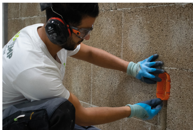
4 Verzamel het afval van je hennepblokken en maal het. Meng vervolgens met ProKalk bindmiddel in een 50/50 verhouding. Bevochtig het verkregen mengsel met water om een homogeen, lichtvochtig mengsel te verkrijgen. Vul de holtes met het mengsel.
