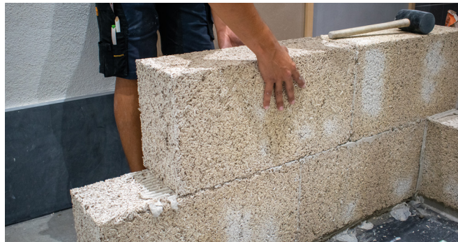
8 Leg de blokken op een dunne lijmlaag van 3mm.
